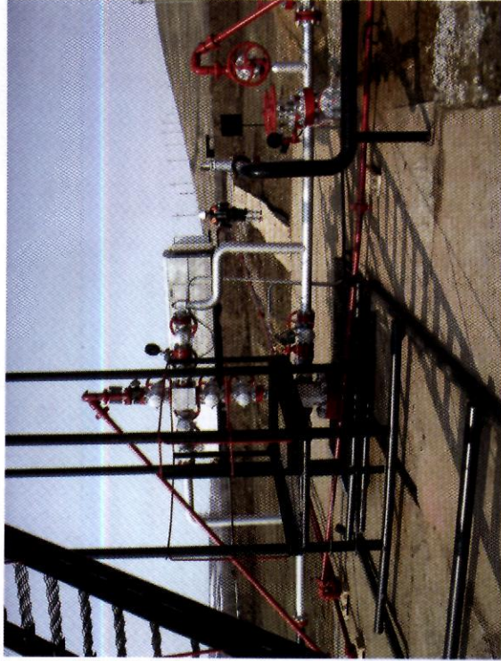
Фото 2. Установка замерная трехфазная передвижная УЗТ-6,0-600
